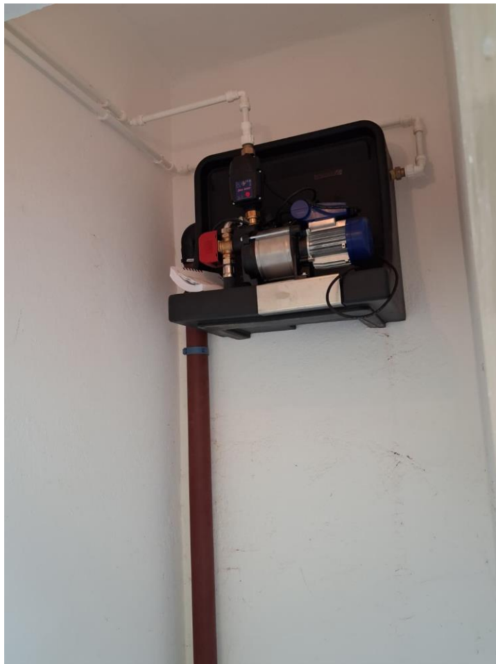
Abb. 01: Trinkwasser Nachspeisemodul, Pumpe
