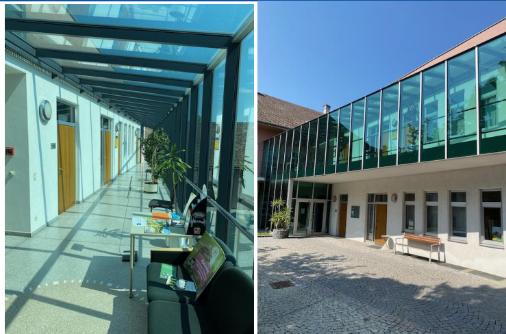
Fotos: Verglaster Eingangsbereich: VOR Montage Beschattung
