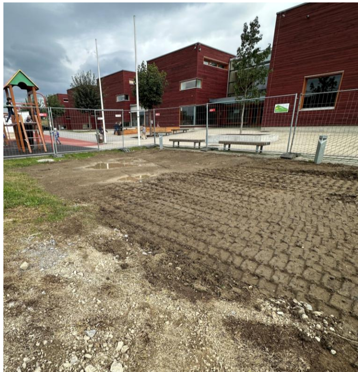
Abbildung 5: Entsiegelung Pflanzbereich Klimabäume (Quelle: Marktgemeinde St. Ruprecht/R.)
