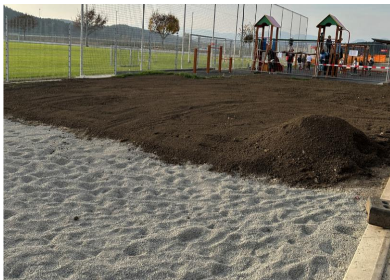
Abbildung 9: Herstellung Pflanzbereich für Klimabäume (Quelle: Marktgemeinde St. Ruprecht/R.)
