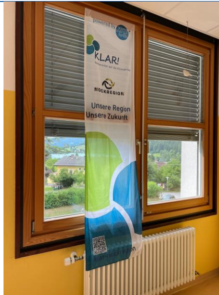
Abbildung 2: Neue Jalousien in den süd-östlich ausgerichteten Klassenzimmern
