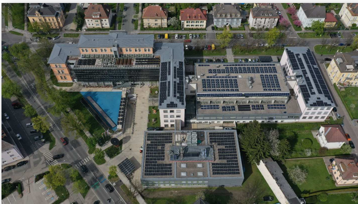
Abbildung 10 - Luftansicht Dachflächen HTL1 zu Projektende 2025, © HTL1
