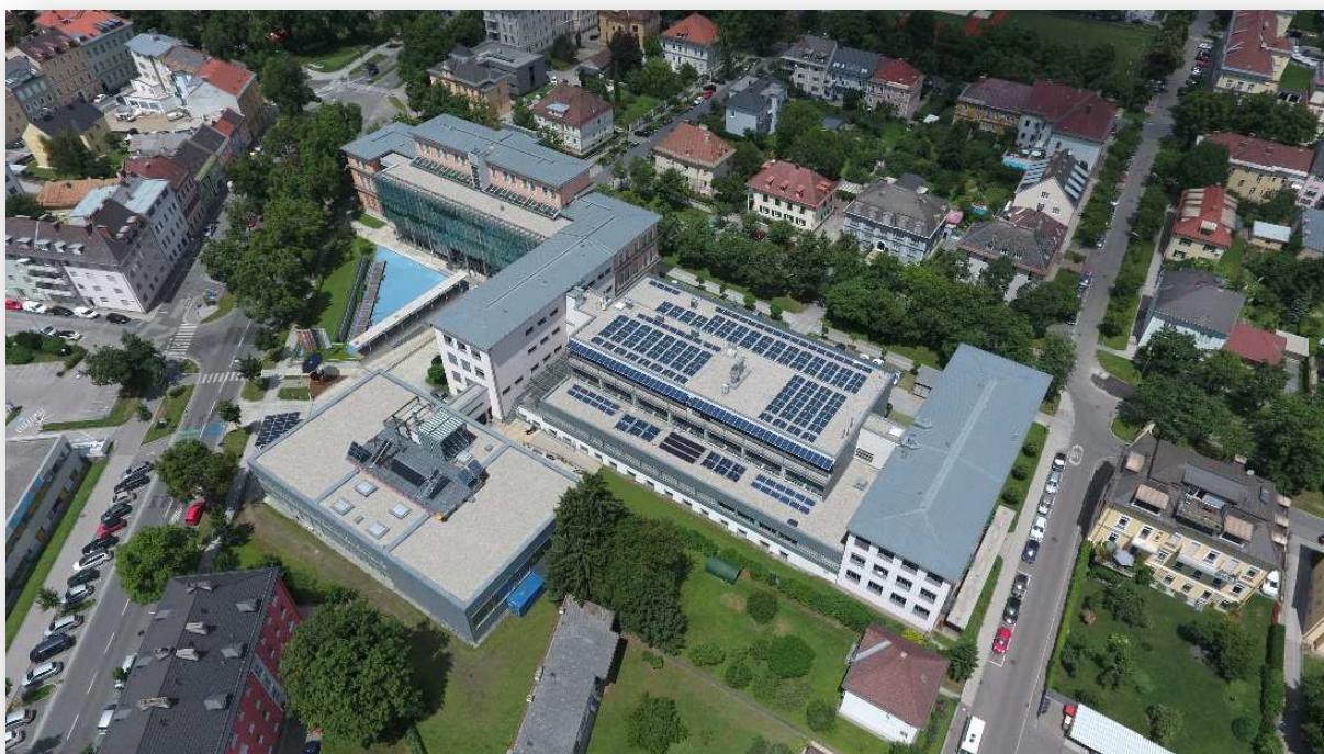
Abbildung 9 - Luftansicht Dachflächen HTL1 zu Projektbeginn 2022, © HTL 1
